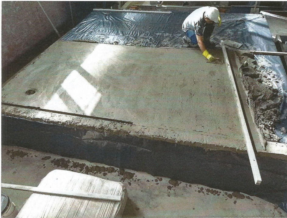
Figura – Montagem do sistema construtivo
